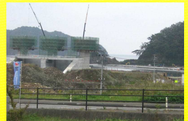
防潮堤を作る工事が行われています
