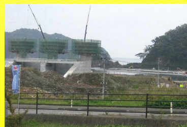
防潮堤を作る工事が行われています
